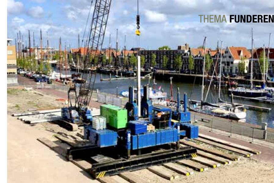
Fundeermachine Pile Pusher Pro. (Beeld: A.P. van den Berg)
